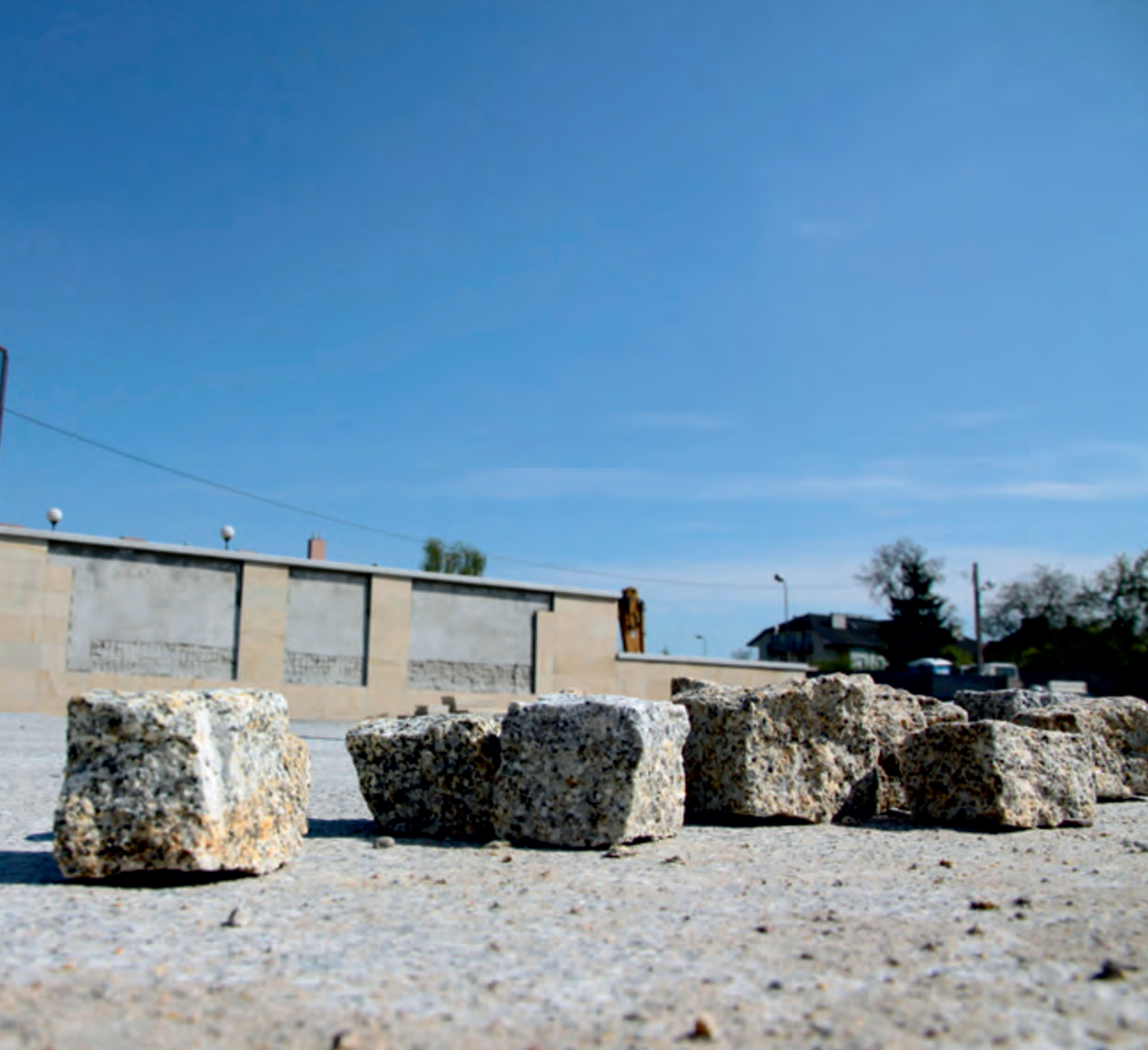
Budowa muru oporowego oraz nowej nawierzchni na północno-wschodniej części Placu Jana Kilińskiego w Zgierzu.
