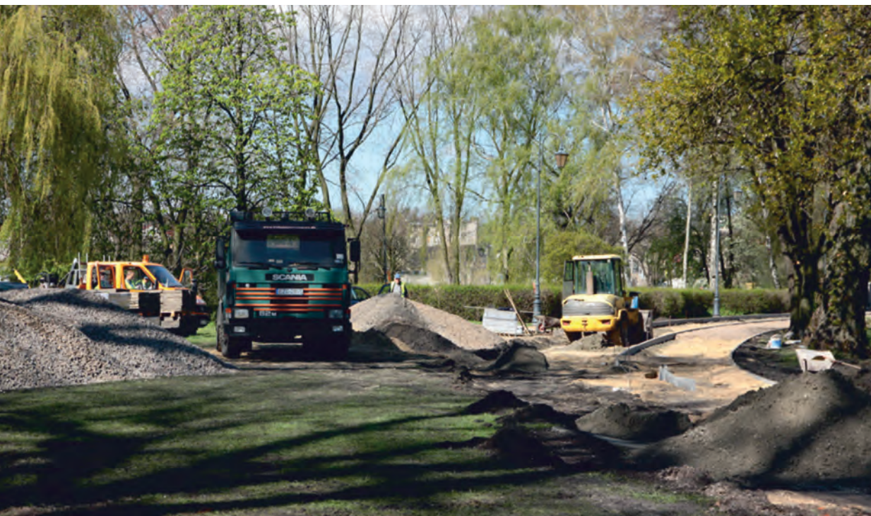
Budowa nowych alejek w Parku Miejskim w Zgierzu.
