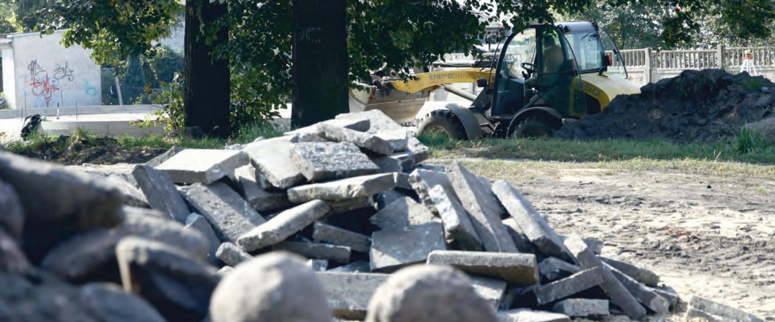
Roboty budowlane na terenie tzw. „kwartału ulic” w Zgierzu.
