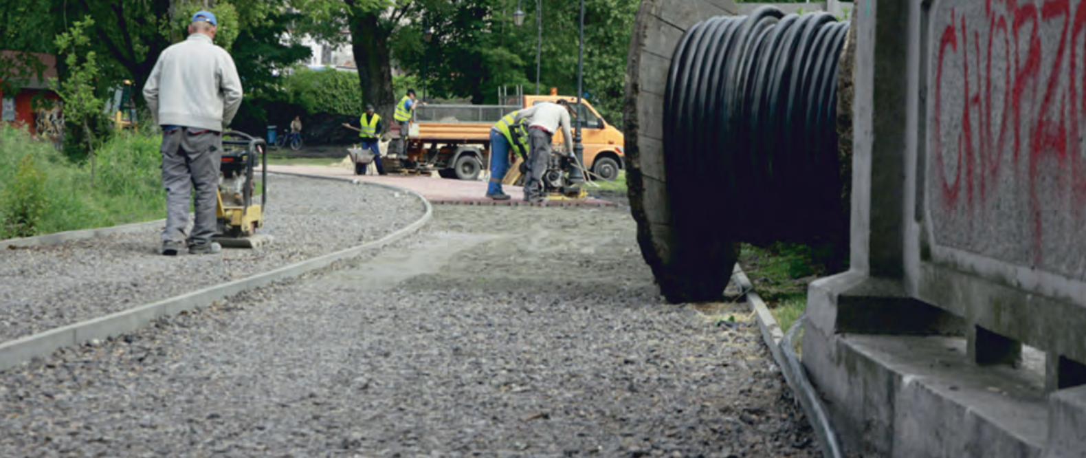
Prace budowlane w Parku Miejskim w Zgierzu.
