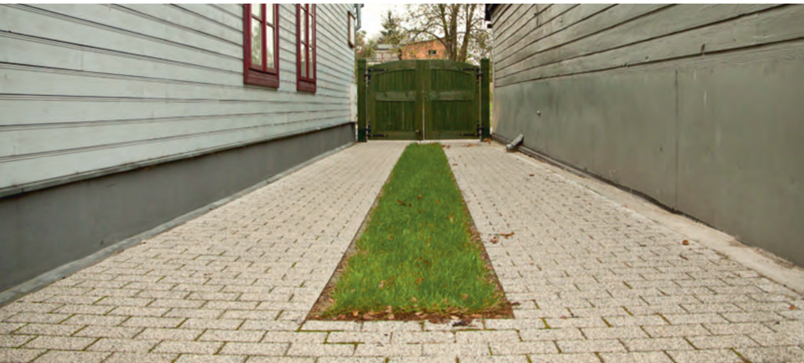
Wjazd do ogrodu Centrum Kultury Dziecka w Zgierzu po rewitalizacji.
