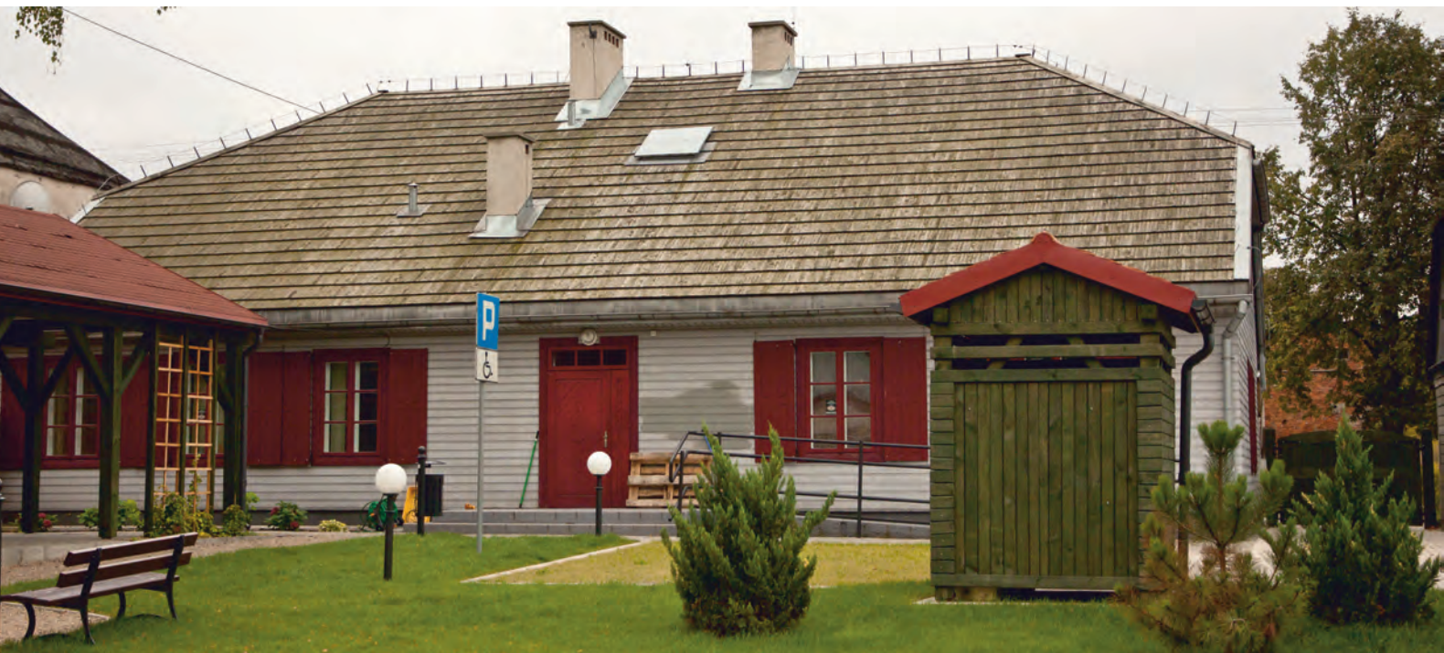
Zagospodarowanie ogrodu Centrum Kultury Dziecka w Zgierzu po rewitalizacji.
