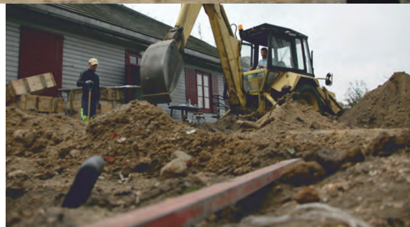
Prace ziemne w ogrodzie Centrum Kultury Dziecka w Zgierzu.
