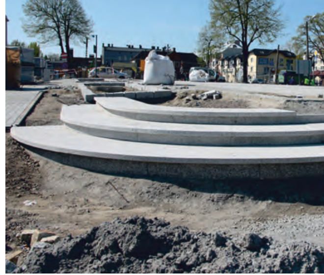
Budowa schodów na północno-wschodniej ćwiartce Placu Jana Kilińskiego w Zgierzu.
