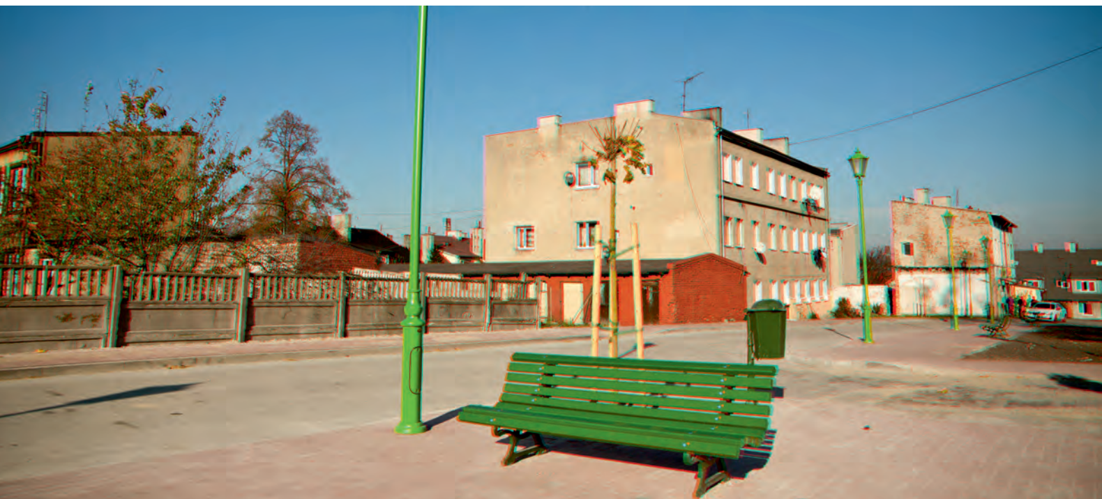
(3D). Nowe nawierzchnie, mała architektura i oświetlenie na terenie zrewitalizowanego tzw. „kwartału ulic w Zgierzu.
