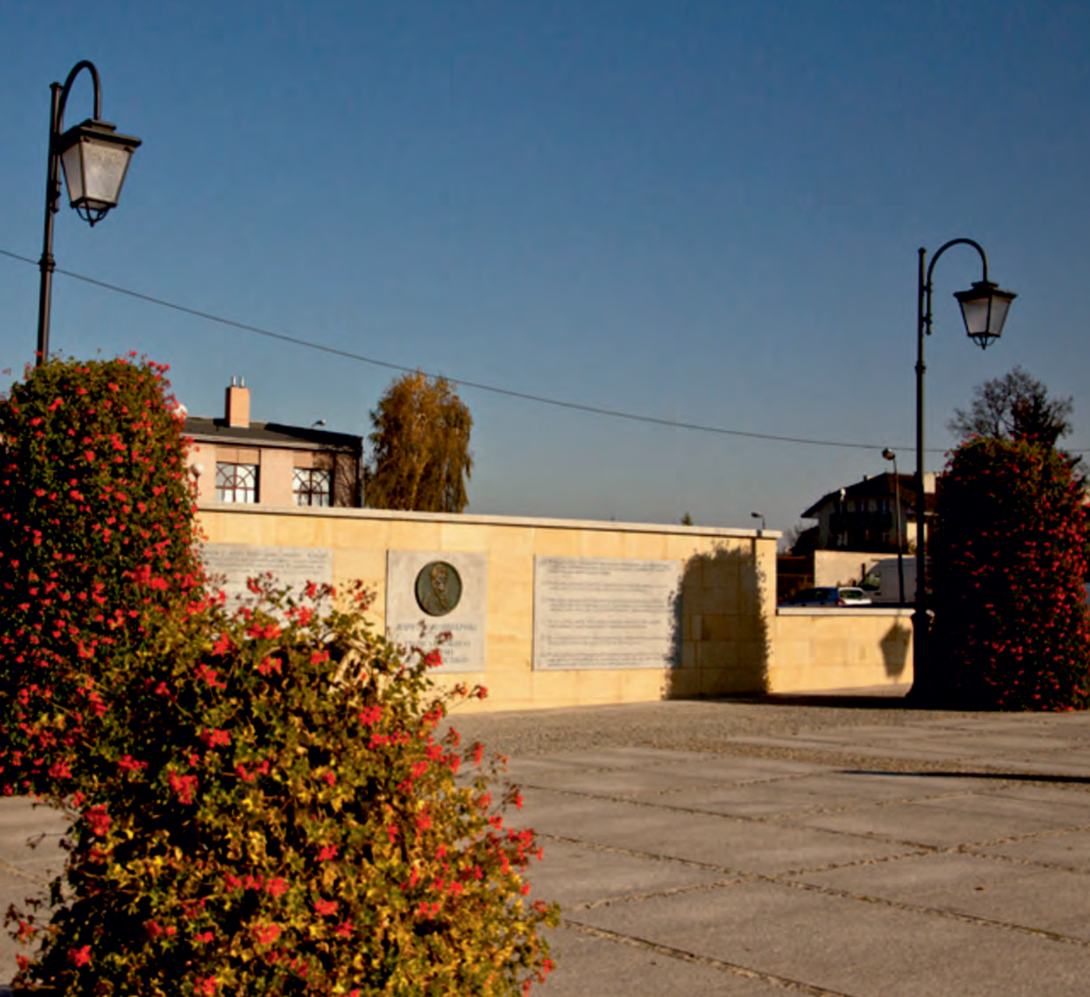
Mur oporowy i nowa nawierzchnia na północno-wschodniej części Placu Jana Kilińskiego w Zgierzu po rewitalizacji.
