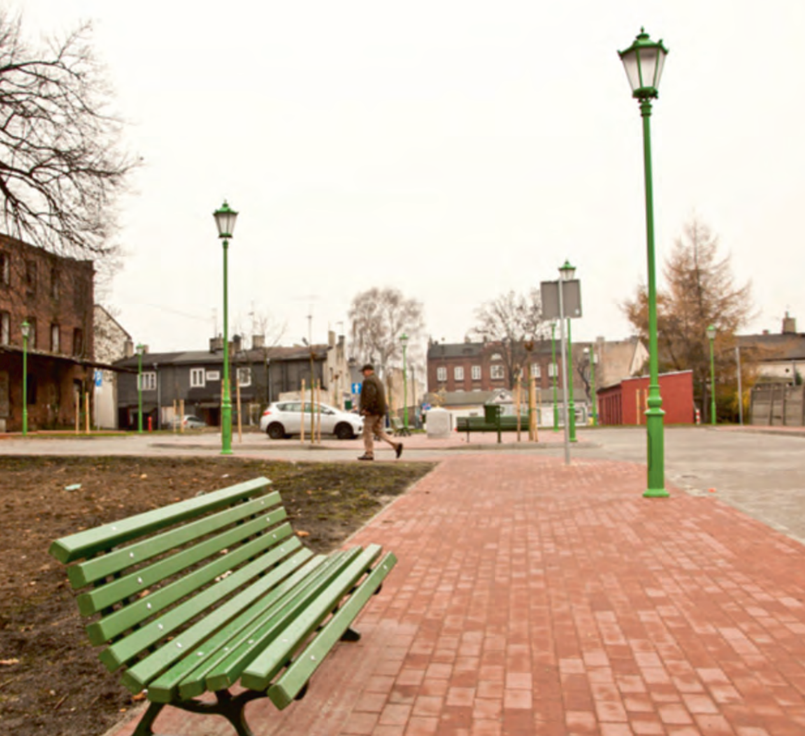
Nowe nawierzchnie, mała architektura i oświetlenie na tzw. „kwartale ulic” w Zgierzu.
