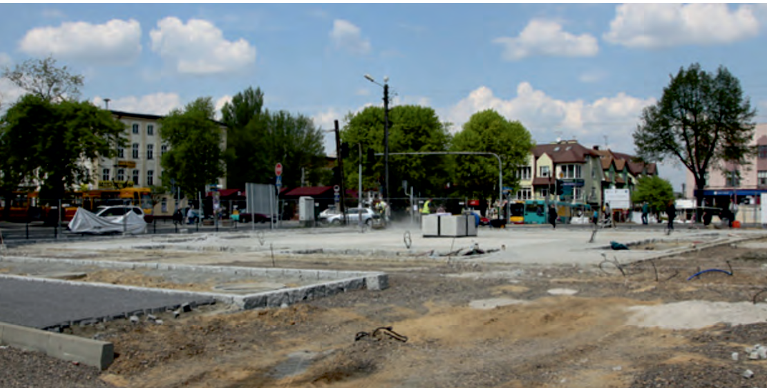
Prace budowlane na południowo-wschodniej ćwiartce Placu Jana Kilińskiego w Zgierzu.
