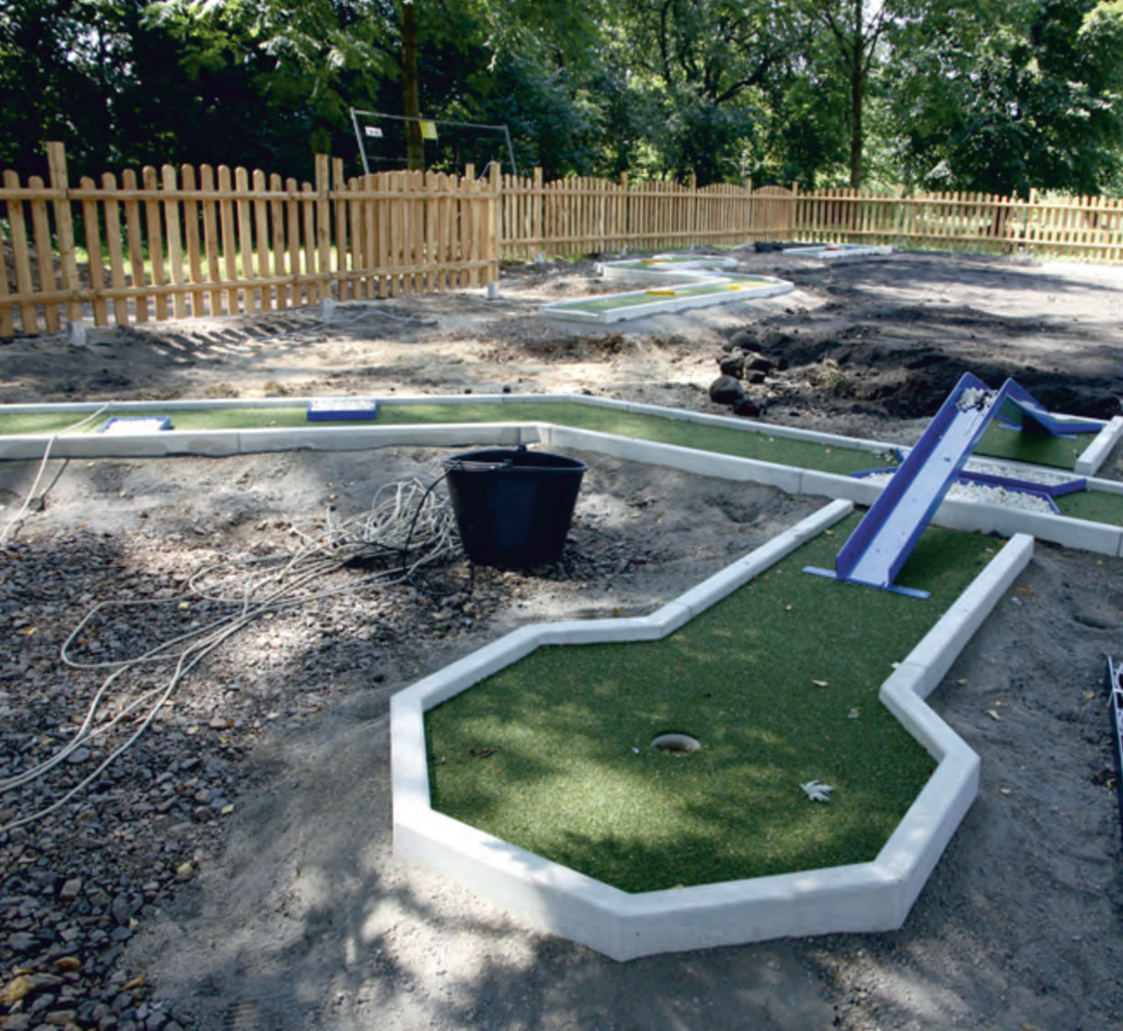
Budowa pola do mini golfa w Parku Miejski w Zgierzu.
