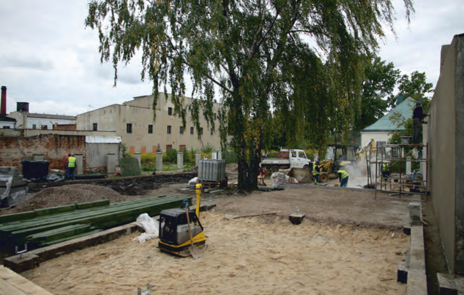
Prace budowlane w ogrodzie Centrum Kultury Dziecka w Zgierzu.
