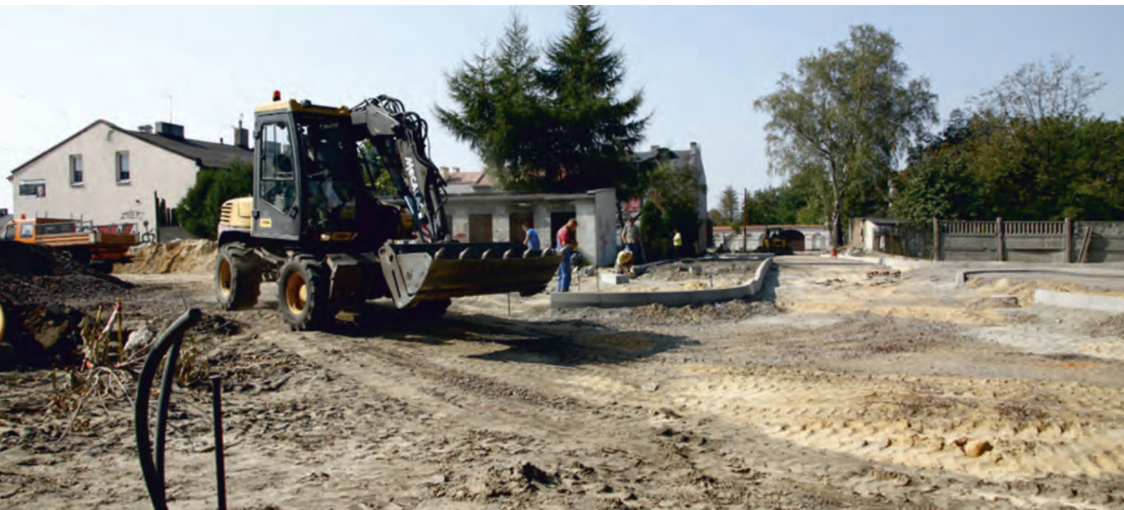
Budowa nowych nawierzchni na tzw. „kwartał ulic” w Zgierzu.
