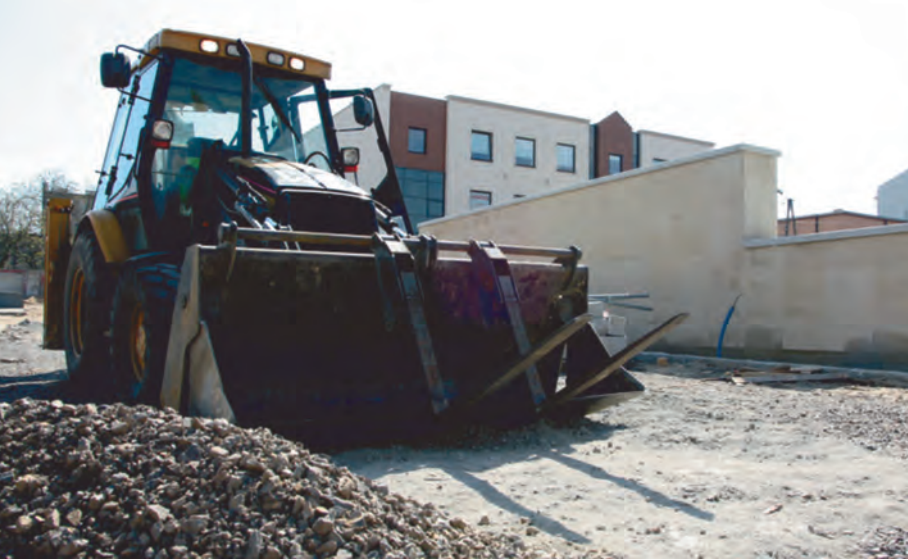
Prace budowlane na północno-wschodniej części Placu Jana Kilińskiego w Zgierzu.
