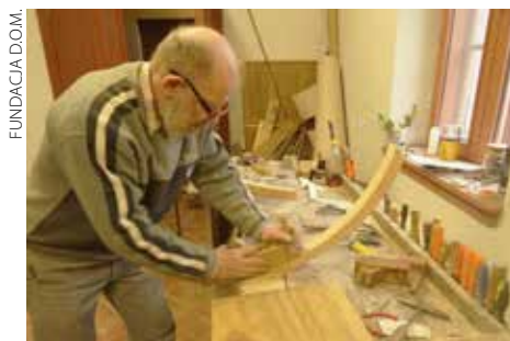
Prace stolarskie przy budowie konstrukcji baldachimu
