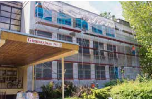
Jednym z największych projektów inwestycyjnych w Zgierzu jest warta ponad 56 mln zł termomodernizacja placówek oświatowych. Realizacja zakończy się w III kwartale przyszłego roku
