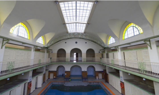
Remont wnętrza jednego z najpiękniejszych zgierskich budynków może rozpocząć się w drugiej połowie roku
