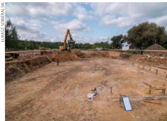
Trwa budowa nowego bloku komunalnego
