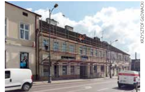
Remont kamienic przy placu Jana Pawła II
