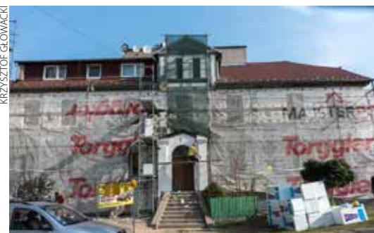
Remont kamienic komunalnych przy ulicy Długiej
