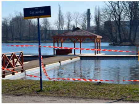
Kolejna inwestycja w parku miejskim. Budowę konstrukcji rozpoczęto pod koniec marca
