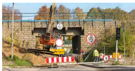
PKP remontuje cztery wiadukty w Zgierzu. Na zdjęciu prace przy Szczawińskiej
