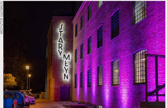
Nowoczesny, ale i nawiązujący do zgierskiej tradycji. Nowy budynek Miejskiego Ośrodka Kultury niezmiennie powstał w uzgodnieniu z konserwatorem zabytków. Wyglądem nawiązuje do istniejącego w tym miejscu od początku XX wieku zbożowego młyna braci Braun. Do budowy elewacji wykorzystano m.in. cegły pochodzące z historycznej budowli.
