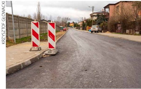
Nowa utwardzona nawierzchnia ulic Reja i Norwida
