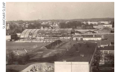
Hała MOSiR w budowie
