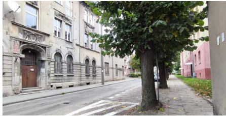
Na odcinku od ul. Mielczarskiego do ul. Spółdzielczej remont obejmie jezdnię i chodniki
