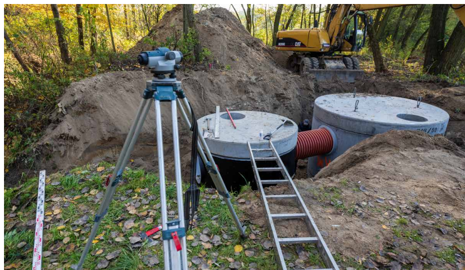
(rk) Zakończyła się budowa kanalizacji deszczowej w przebudowywanej ul. Przygranicznej
