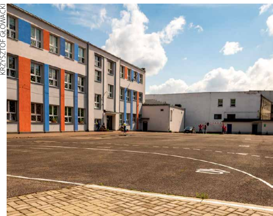
To już ostatnie dni boiska przy SP4 w takim stanie
