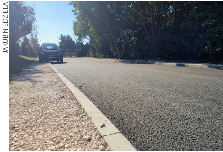
Zmodernizowana ulica Maczka. Mieszkańcy oczekiwali przebudowy dróg osiedlowych
