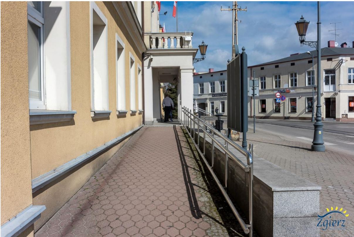
Podjazd dla wózków do wejścia głównego do budynku urzędu przy pl. Jana Pawła II numer 16
