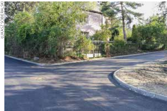
Kolejne zgierskie ulice zyskują nowe nawierzchnie. Na zdjęciu ulica Chełmska
