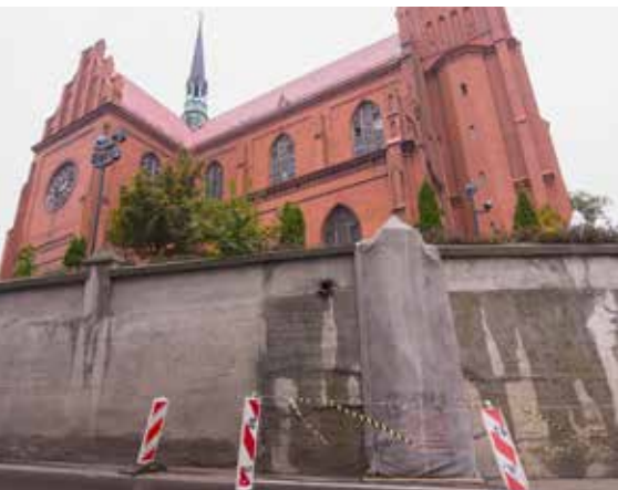
Spękany mur został zabezpieczony
