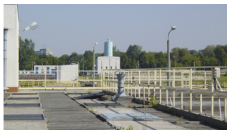
Zgierska oczyszczalnia ścieków
