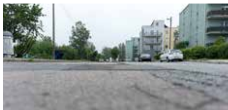
Miasto planuje przebudowę ulicy Łąkowej
