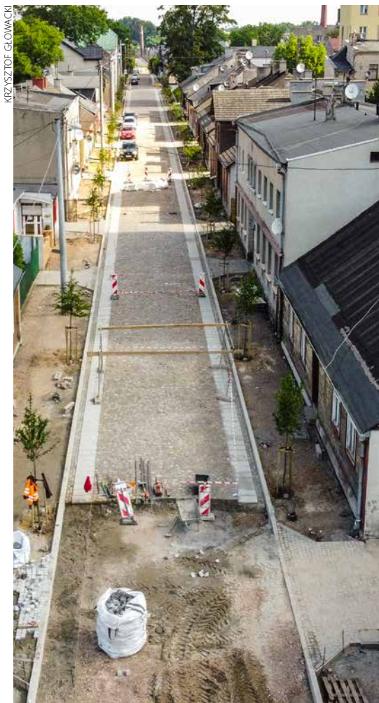
Ulica Narutowicza w trakcie prac budowlanych
