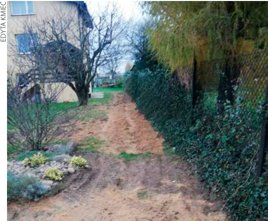
Po zakończeniu drugiej edycji projektu w Zgierzu będzie ponad 130 budynków więcej przyłączonych do zbiorczej sieci kanalizacyjnej
