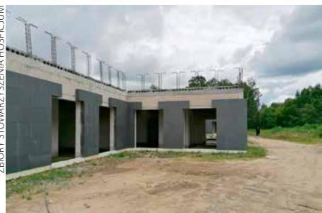
Budowa hospicjum trwa od 27 lat. Przy wsparciu darczyńców jest szansa na ukończenie większości prac pod koniec tego roku
