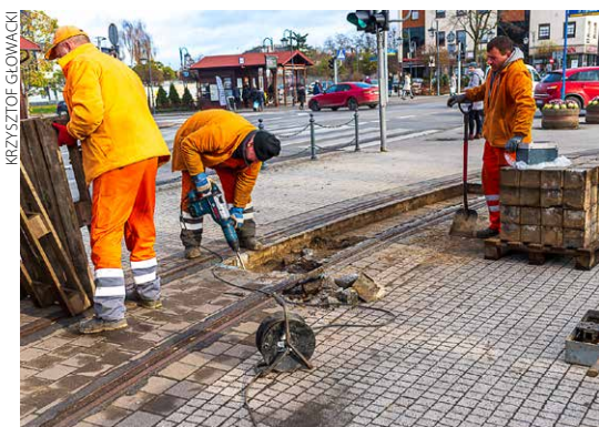
Prace na placu Kilińskiego, zgierskiej krańcówce tramwaju
