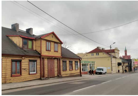
Na pierwszym planie budynek przy Długiej 22, który ma być modernizowany w 2022 roku. Na drugim planie już odnowione kamienice
