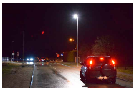
Lampy doświetliły ulicę i część wiaduktu
