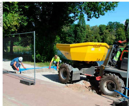
Prace remontowe w parku
